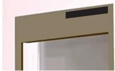
Pour une pose sous linteau inversé, alignez le volet à votre façade avec le coffre orienté vers l'intérieur.
